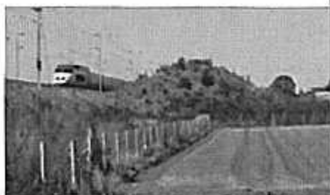
Merlon de protection
